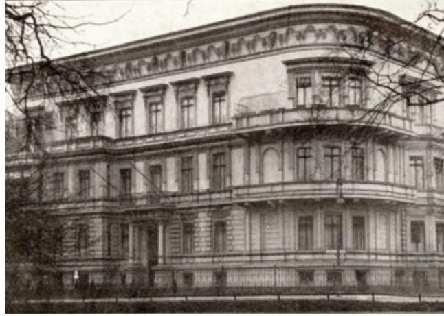
Die Hessische Gesandtschaft in Berlin, Außen- und Innenansicht, 1928
